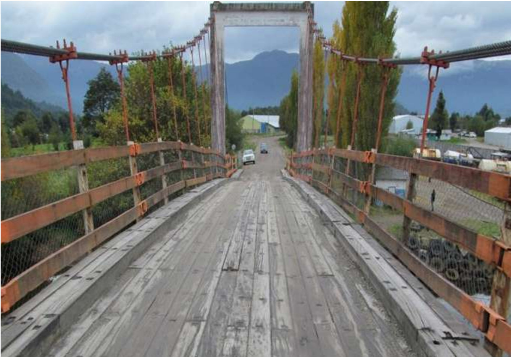
Foto: Puente Los Palos, Ruta X-528, Región de Aysén. Construido con madera preservada; 26 años en servicio.
